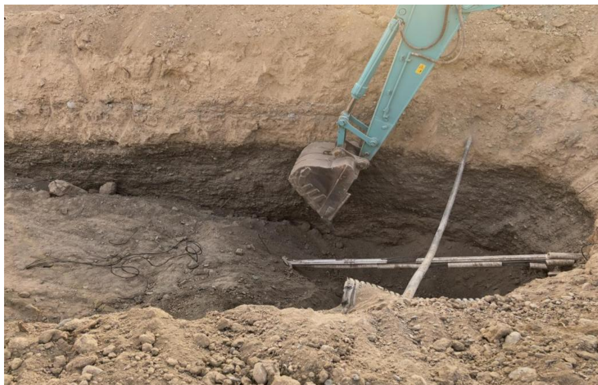
图 5 坍塌基坑西侧顶部照片
