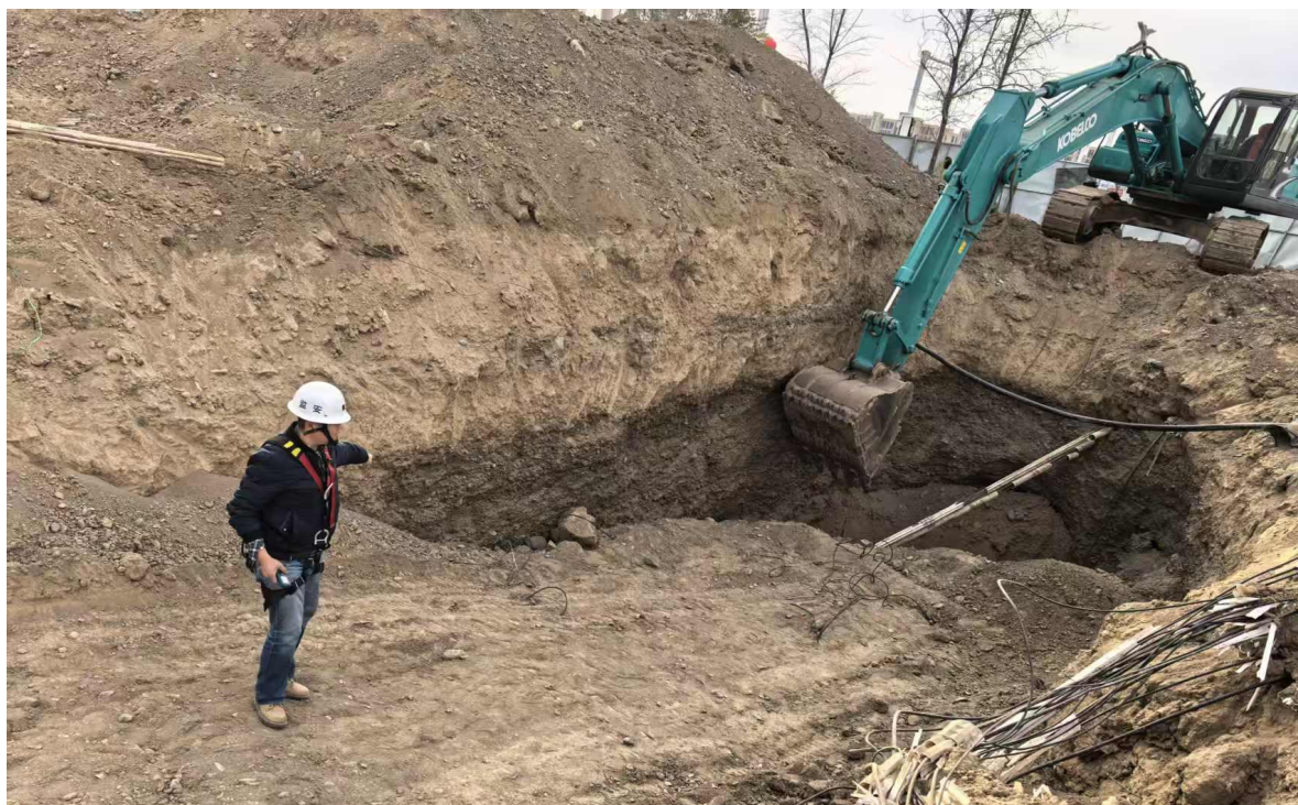
图 4 坍塌基坑正面照片
